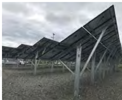
設置現場:日本北海道 架台種類:地上設置型架台システム 設置時間:2018年8月 設置容量:5MW
