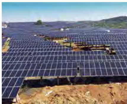
設置現場: 浙江 安吉 架台種類: 地上設置型架台システム 設置時間: 2017年1月 設置容量: 35MW
