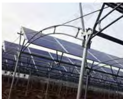
設置現場: 淮安 五里 架台種類: ソーラーシェアリング架台 設置時間: 2015年8月 設置容量: 5MW
