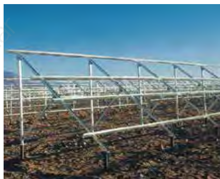
設置現場: 甘肅 永昌 架台種類: 地上設置型架台システム 設置時間: 2015年10月 設置容量: 20MW
