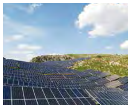
設置現場: 雲南 丘北県 架台種類: 野立て固定式 設置時間: 2019年12月 設置容量: 40MW
