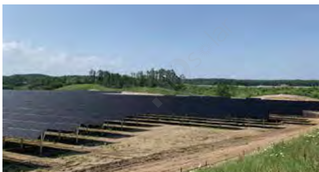
設置現場:日本北海道 架台種類:地上設置型架台システム 設置時間:2019年4月 設置容量:12MW
