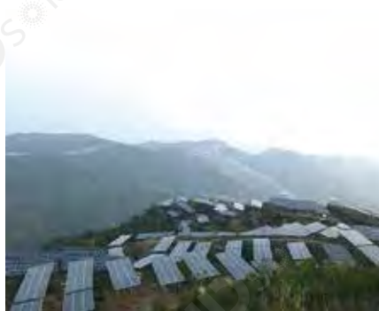
設置現場: 河南 三門峽 架台種類: 地上設置型架台システム 設置時間: 2018年3月 設置容量: 20MW
