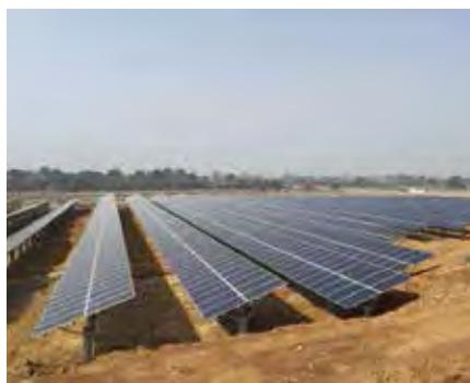
設置現場: 浙江 衢江 架台種類: 地上設置型架台システム 設置時間: 2016年8月 設置容量: 40MW
