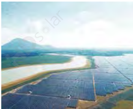
設置現場:ベトナム ダウティエン 架台種類:地上設置型架台システム 設置時間:2018年7月 設置容量:253MW
