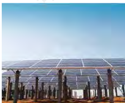
設置現場: 浙江 長興 架台種類: EPCプロジェクト 設置時間: 2017年7月 設置容量: 90MW
