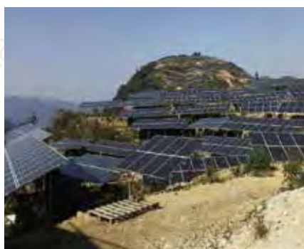
設置現場: 浙江 松陽 架台種類: 地上設置型架台システム 設置時間: 2018年5月 設置容量: 35MW
