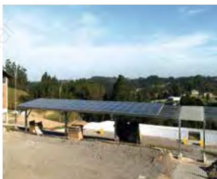
設置現場: ブラジル 架台種類: ソーラーカーポート 設置時間: 2017年10月 設置容量: 221.6KW
