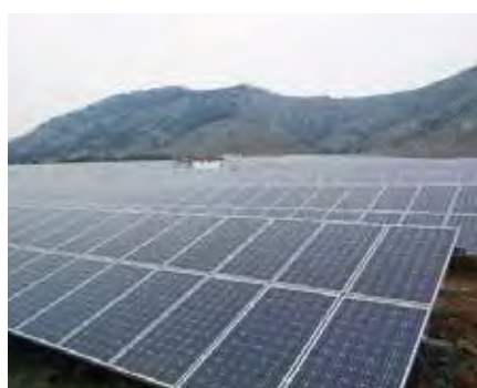
設置現場: 山東 棗荘 架台種類: 地上設置型架台システム 設置時間: 2015年12月 設置容量: 10MW
