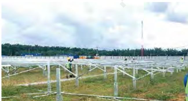
設置現場:マレーシア 架台種類:地上設置型架台システム 設置時間:2019年12月 設置容量:45MW
