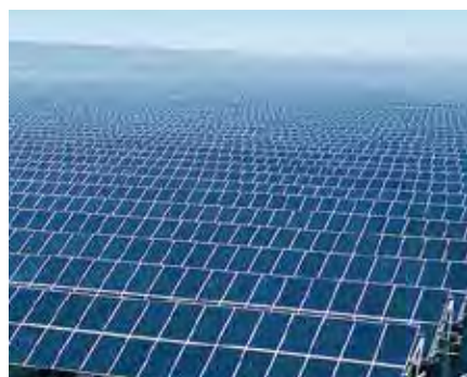
設置現場: 江蘇 泰州 架台種類: ソーラーシェアリング架台 設置時間: 2014年4月 設置容量: 80MW
